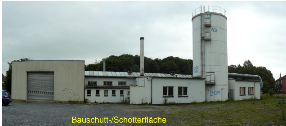
Bild 01: Ansicht Westfassade der Fabrikhalle (ehem. Schreinerei) (Blickrichtung E, Datum 22.06.11)
