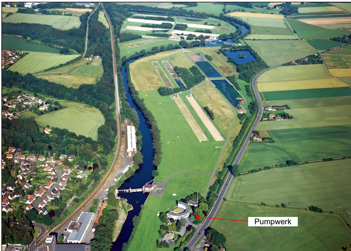
Abbildung 10: Wasserwerk Halingen – Pumpwerk und Wassergewinnungsgelände
