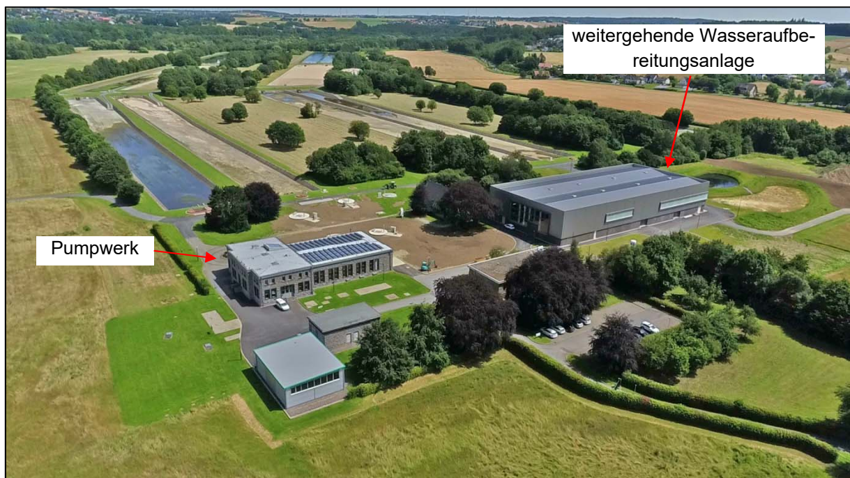
Abbildung 8: Wasserwerk Echthausen - Wassergewinnungsgelände, Pumpwerk und Wasseraufbereitungsanlagen
