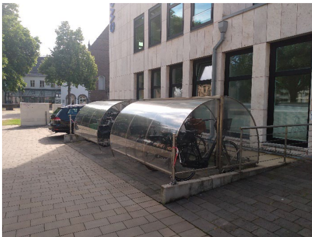
Beispiel Abstellanlage GWG Sendenhorst Stadt Sendenhorst
