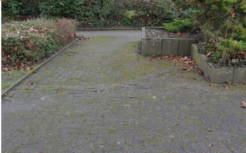
Nicht barrierefreier Gehweg in der Stadt Sendenhorst - Eigene Aufnahme
