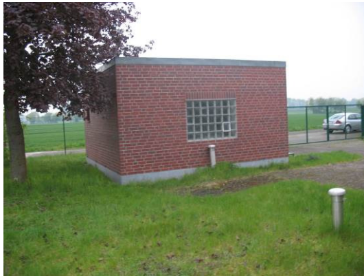
Abb. 5 Pumpenhaus westlich des Plangebiets.
