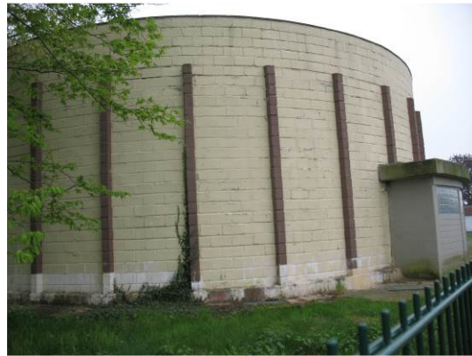
Abb. 6 Tropfbecken im Osten des Plangebiets.
