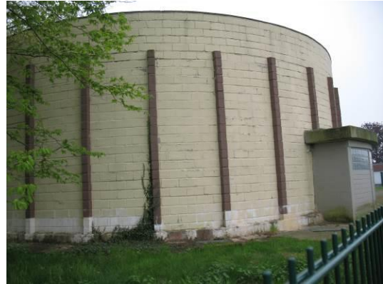
Abb. 8 Tropfbecken im Plangebiet.
