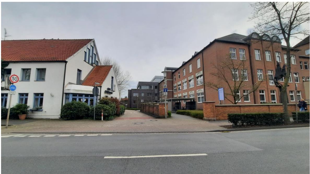
Abbildung 3: bestehende Zufahrt Pennigstiege (Gnegel)
