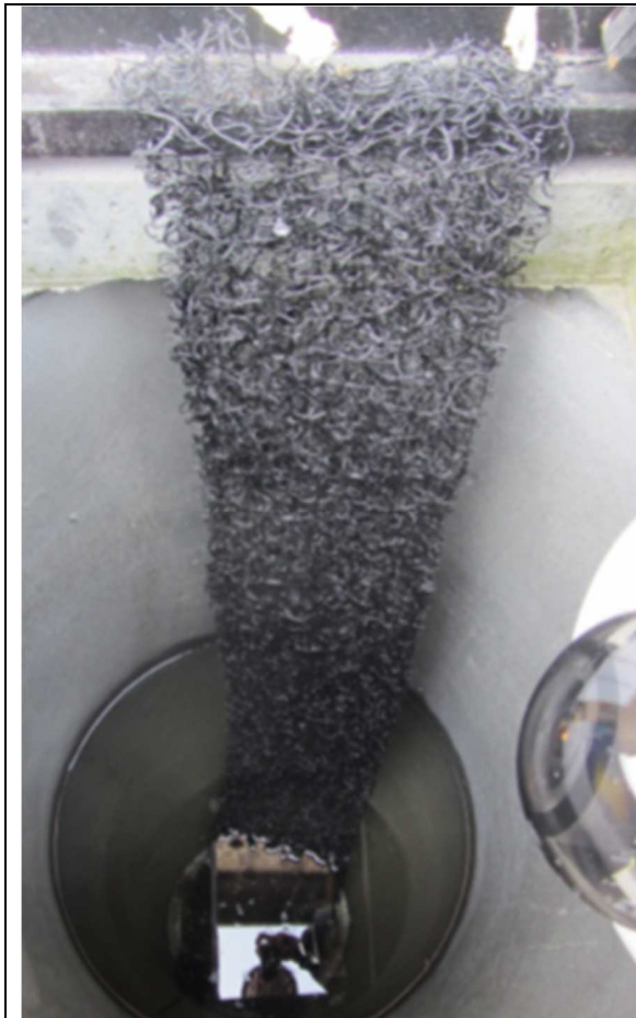
Foto 11**: Alternativ können auch Krallmatten installiert werden (Quelle für Vertrieb, Einbau und Funktionsweise: www.karch.ch/karch/de/home/amphibienfordern/in-entwasserungsanlagen.html )
