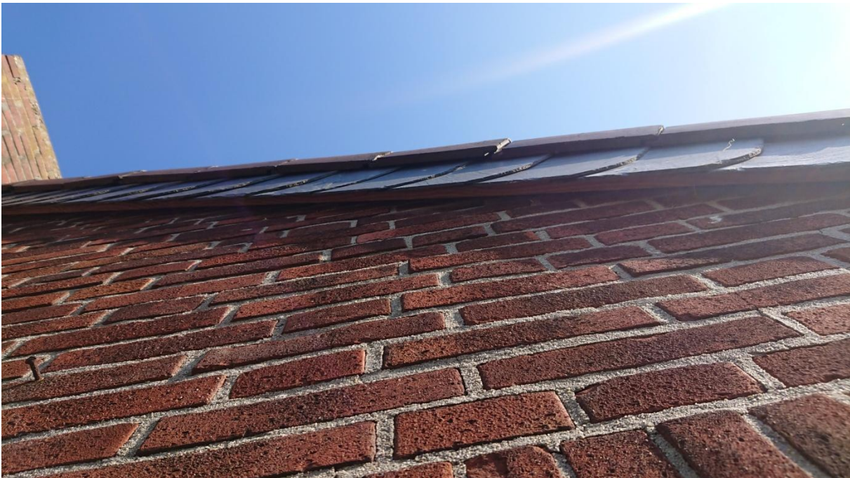
Foto 6: Spalten unter den Schieferplatten (ohne Nachweise)
