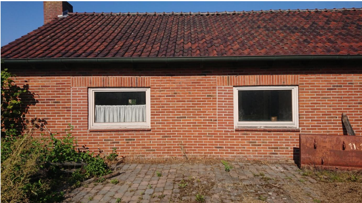
Foto 4: Gebäude Nr. 64 (Seitenansicht)
