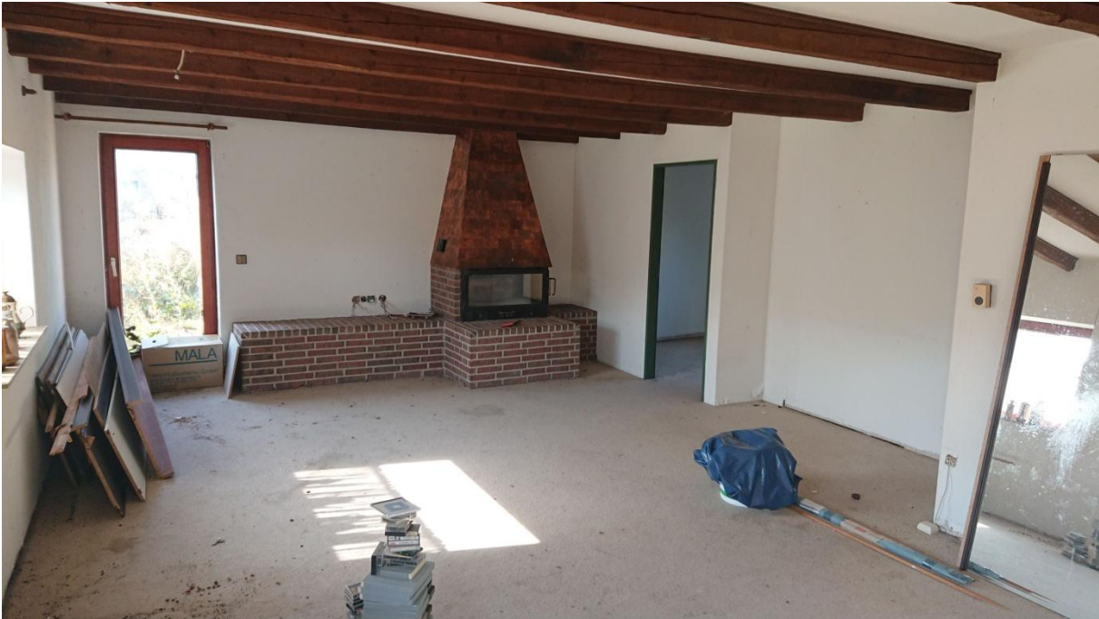
Foto 7: Gebäude Innenansicht Erdgeschoss (Wohnräume)
