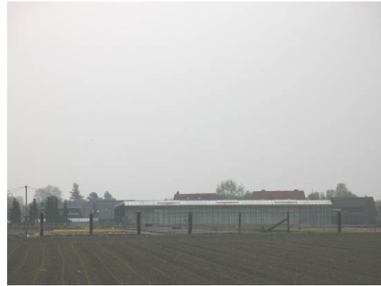
Abb. 21 Gärtnerei mit Gewächshäusern nordöstlich des Plangebiets.
