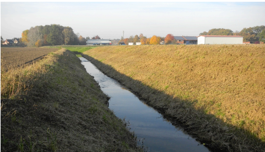
Abb. 4: Ahrenhorster Bach. Blick aus südlicher Richtung. Nov. 2016.
