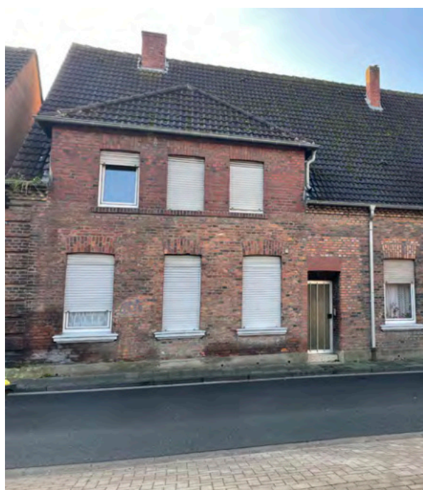
Abb. 24 | Wohngebäude Sendenhorster Str. 12
